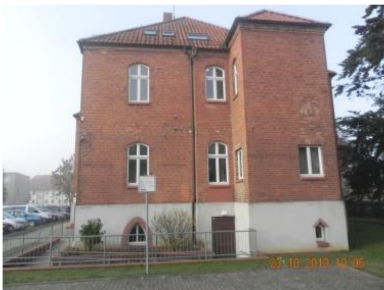
Fassadenfront Herstellung 2. Rettungsweg
